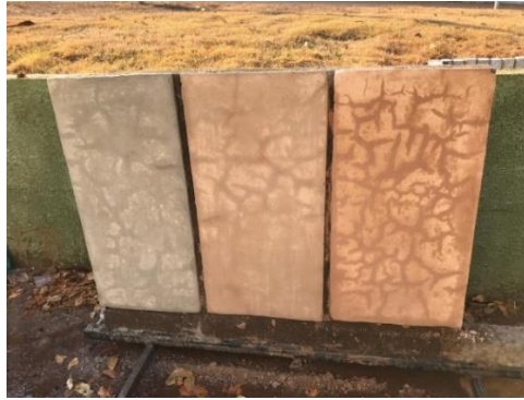
Figura 13 – Parede utilizada para os ensaios de arrancamento e esclerometria Fonte: Autoria própria (2019).
